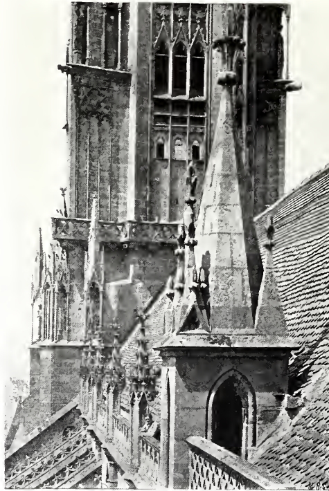
Blick vom südlichen Hahenthurm.
